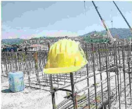
CANTIERE L'edilizia è uno dei settori più a rischio per gli operai
