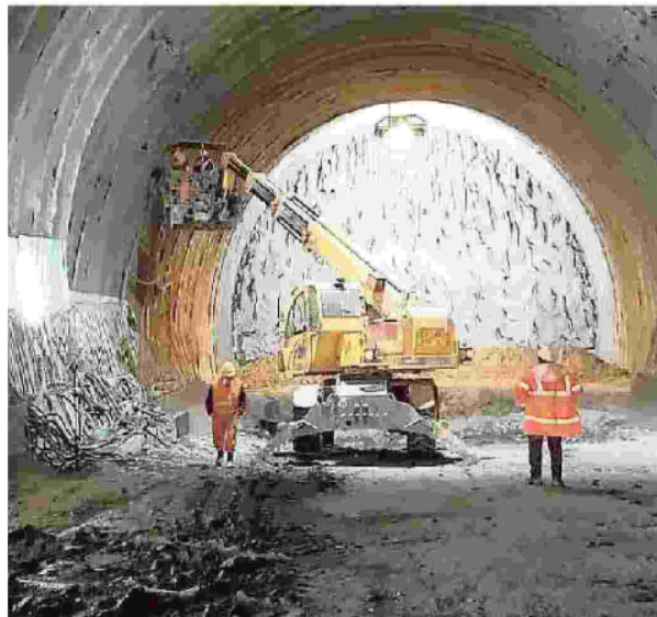
La galleria del Terzo Valico a Voltaggio dove è avvenuta la tragedia
