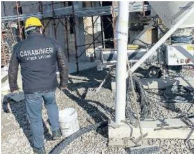
L'ISPEZIONE I carabinieri controllano un cantiere a Mestre
