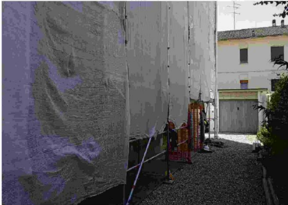
Il cantiere di via Salandri in città, dove lo scorso giugno perse la vita un operaio brasiliano
