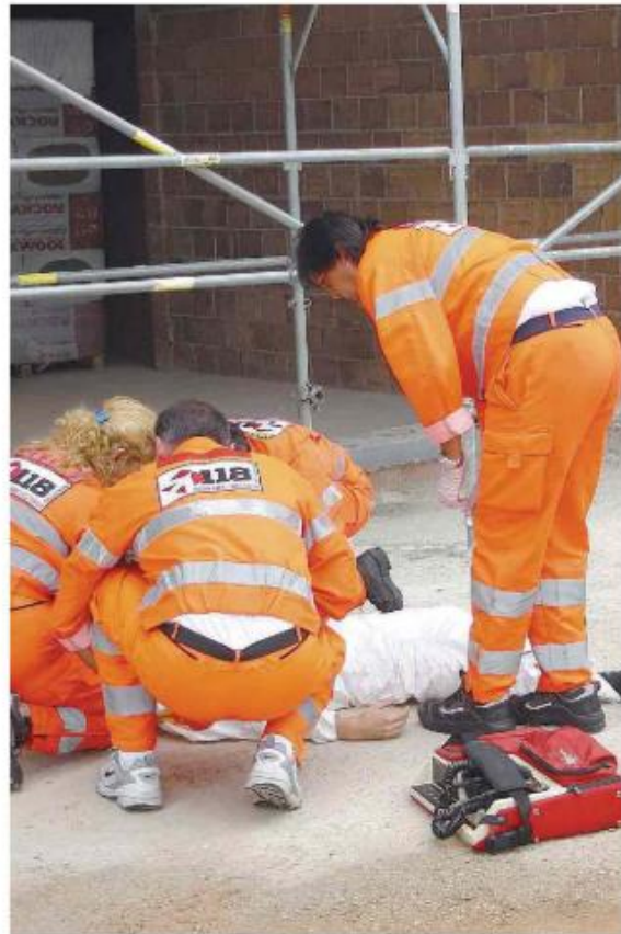
Soccorso Intervento dei sanitari del 118 per un infortunio in un cantiere edile
