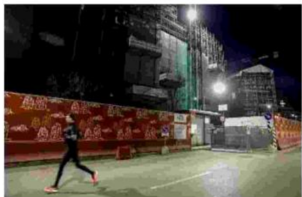
Il cantiere dove il 28 gennaio è morto un operaio a Milano
