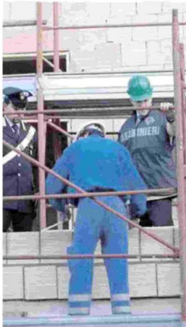
I controlli dello Spesal su un cantiere edile
