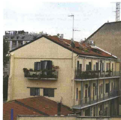
Figura 5 - Esempio di installazioni che possono esporre il lavoratore al rischio di caduta
