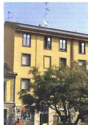
Figura 8 - Edificio ristrutturato con pannelli solari e Linee vita (2011)
