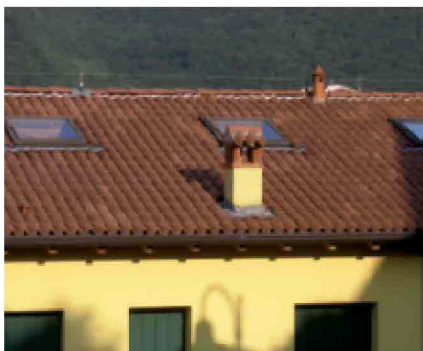
INSTALLAZIONE di linea vita su edificio esistente.
