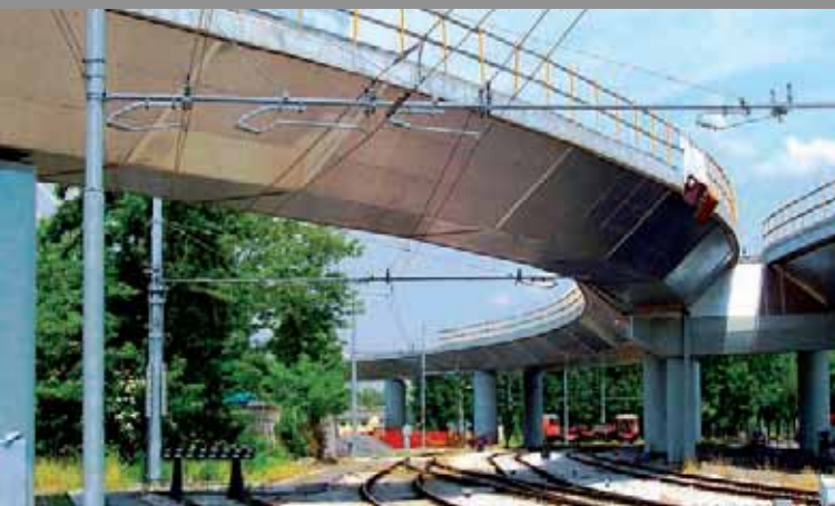
RIVESTIMENTO Sulla struttura inferiore del ponte Darsena sono visibili i pannelli metallici di rivestimento
