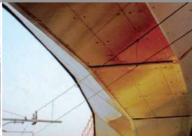
CONTATTO La struttura inferiore del ponte Darsena, in cui è visibile la linea di contatto della struttura ferroviaria
