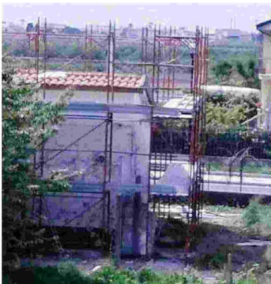
Il cantiere allestito alla contrada Rettifilo di Capaccio
