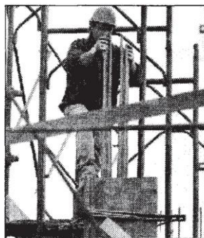
CANTIERE Un operaio al lavoro
