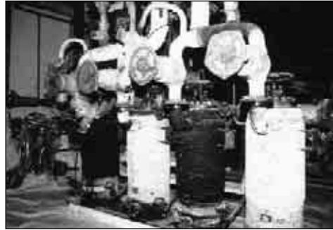
15. Tubazione coibentata con amianto, con evidente danneggiamento e struttura di sostegno.
