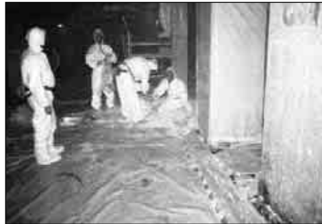
37. Trabatello su ruote utilizzato durante la bonifica. Si notino i fori ove sono inseriti attrezzi, con evidente possibilità di contaminazione interna dei tubi.
