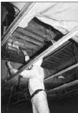
31. Raschiatura amianto spruzzato.
