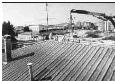
12. Rimozione lastre.
