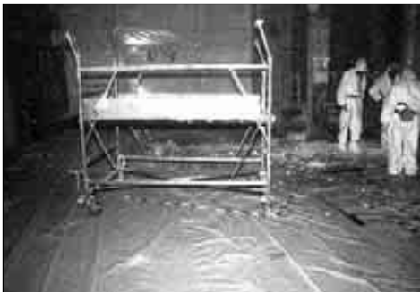
37. Trabatello su ruote utilizzato durante la bonifica. Si notino i fori ove sono inseriti attrezzi, con evidente possibilità di contaminazione interna dei tubi.
