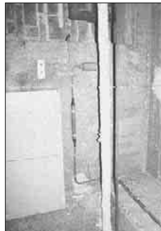
8. Tracce evidenti di lavori eseguiti prima della bonifica.
