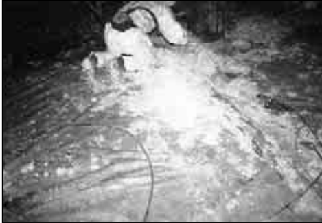
39. Raccolta, in modo improprio, di materiale a secco.
