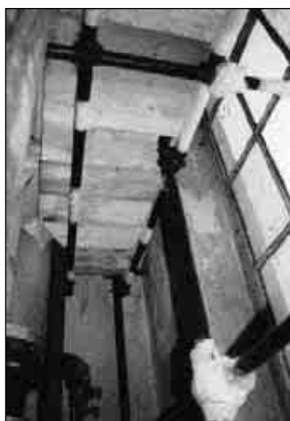
23. Particolare allestimento del ponteggio.
