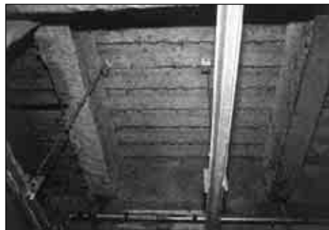
30. Fase intermedia dove si nota l'amianto spruzzato a soffitto.
