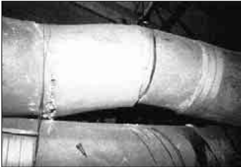
15. Tubazione coibentata con amianto, con evidente danneggiamento e struttura di sostegno.
