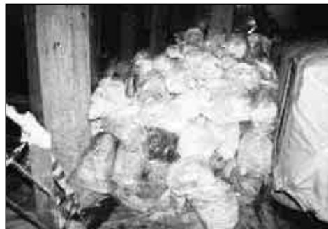
42. Raccolta sacchi, contenenti materiale da bonifica, prima del trasporto all'esterno.
