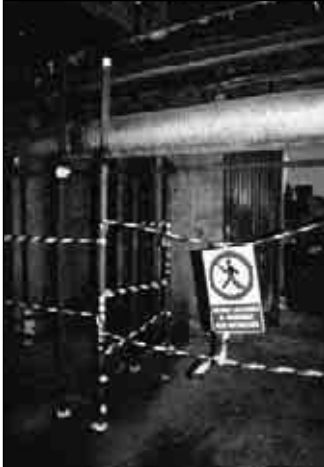
19. Sostegni alle tubazioni e sigillatura terminali ponteggi.
