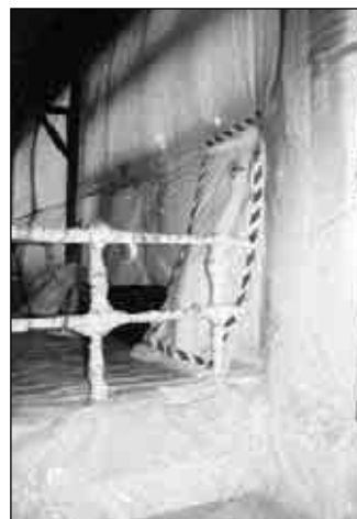
28. Cantiere allestito con estrattore in funzione.
