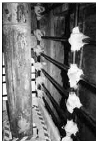
22. Fase di allestimento per la bonifica di un tubo verticale. Struttura a tubi e giunti con soppalchi.
